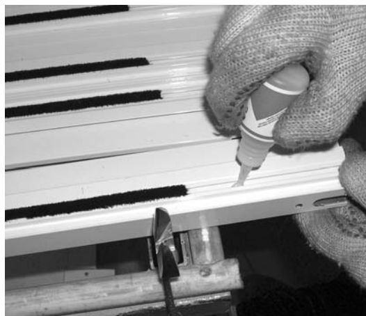
Фото 12. Установка фетровых уплотнений
